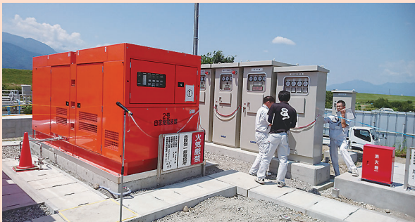
鳴沢川高田排水機場完成
