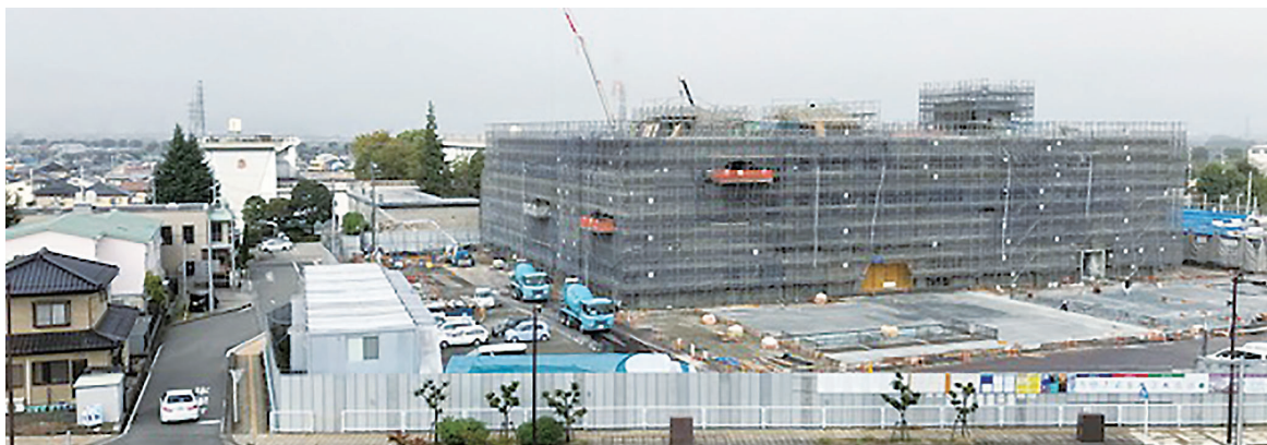
建設進む「青洲高校」校舎
