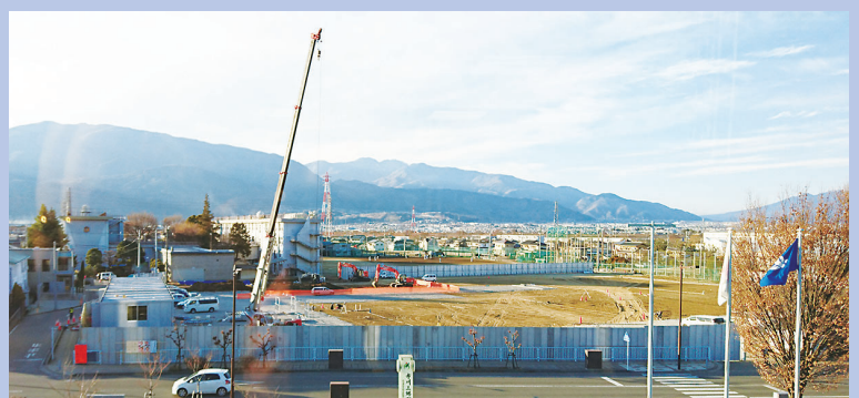
建設が開始された新設高校用地
